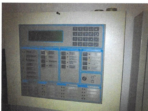
Rys. Centrala systemu sygnalizacji pożarowej oraz czujka dymu
